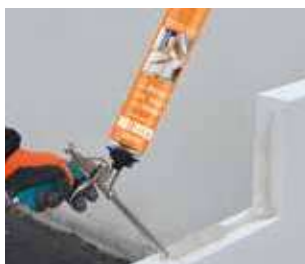
Posa di blocchi GASBETON®
