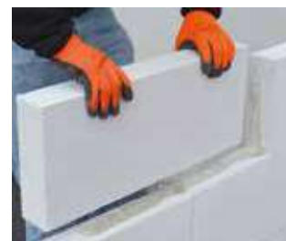
Posa di blocchi GASBETON®
