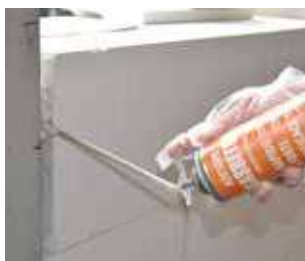
Sigillatura giunti sottili verticali/orizzont.
