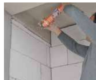
Sigillatura giunti sottili verticali/orizzont.
