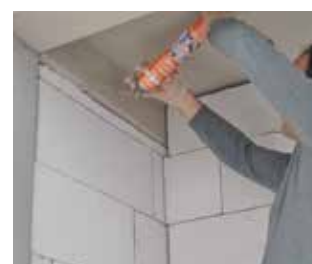
Sigillatura giunti sottili verticali/orizzont.
