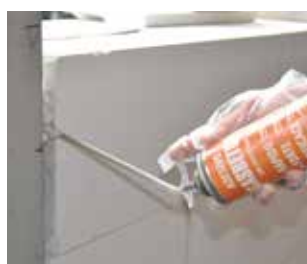
Sigillatura giunti sottili verticali/orizzont.
