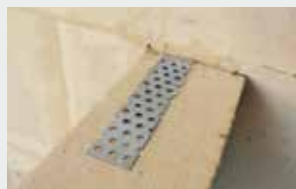
Connettore piatto preforato per ancoraggio tra pareti ortogonali
