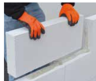
Posa di blocchi GASBETON®
