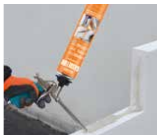
Posa di blocchi GASBETON®
